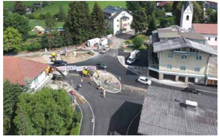
Der neue Kreisverkehr sorgt für mehr Sicherheit im Zentrum
