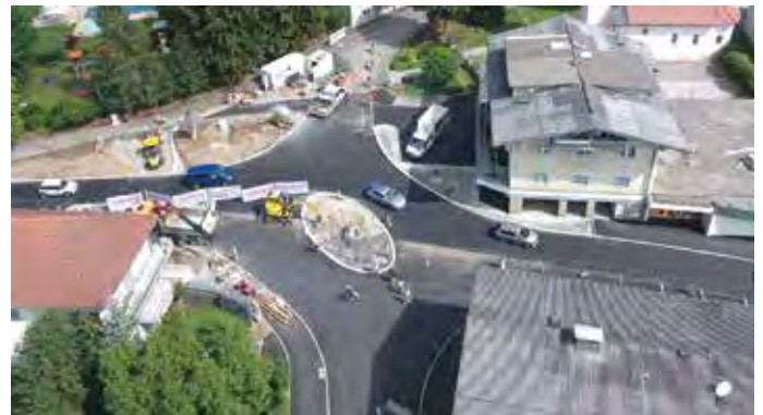
Der neue Kreisverkehr in der Phase der Fertigstellung
