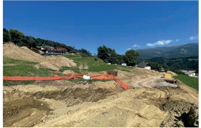
Mitten auf der Baustelle der neuen Kogler-Umfahrung
