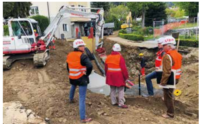
Die Bauarbeiten schreiten gut voran!
