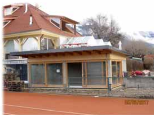
Clubraum in der Bauphase Anfang März
